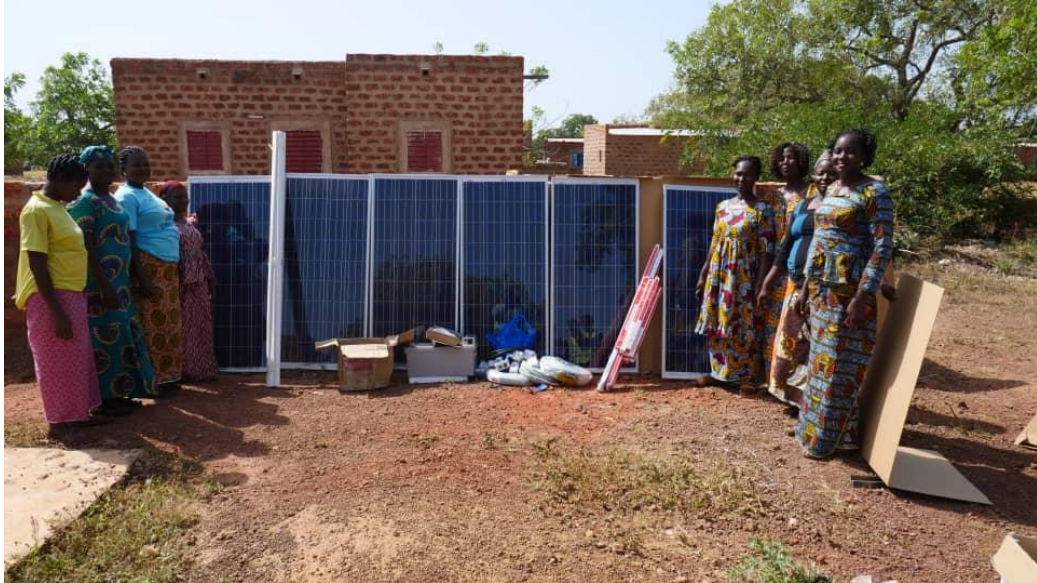
Die Kinder und die Frauenkooperative mit den Installationsmaterialien
